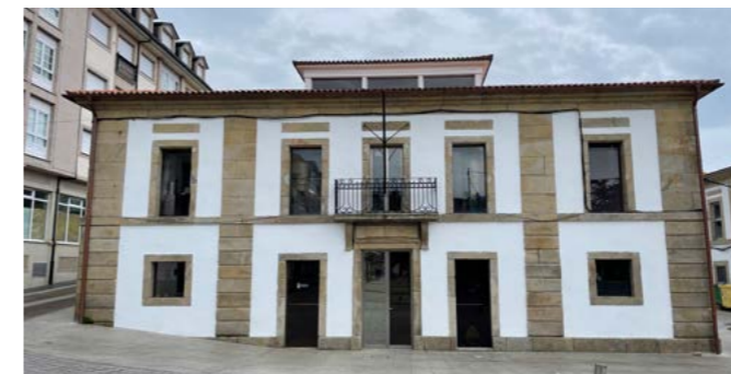
O mercado municipal despois das obras de mellora
