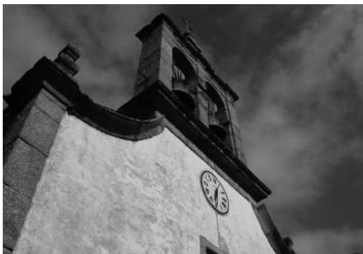
Fachada e campanario da igrexa parroq. Construído no ano 1796
