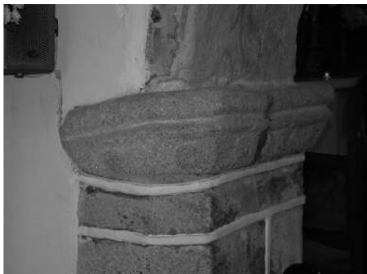
Detalle dos adornos no arco da Capela de San Miguel. Igrexa de St a M a da Pedra
