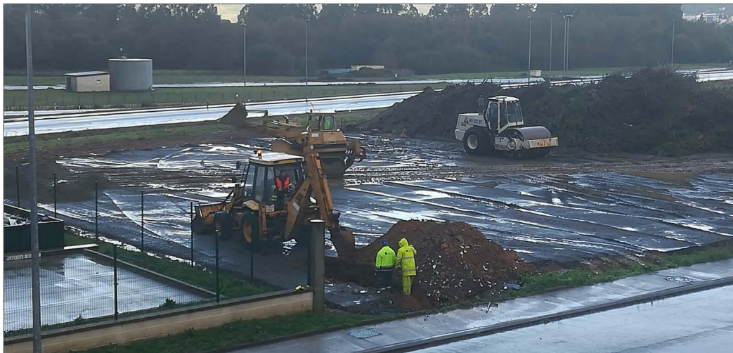
Obra de acondicionamento do depósito de plásticos agrícolas
