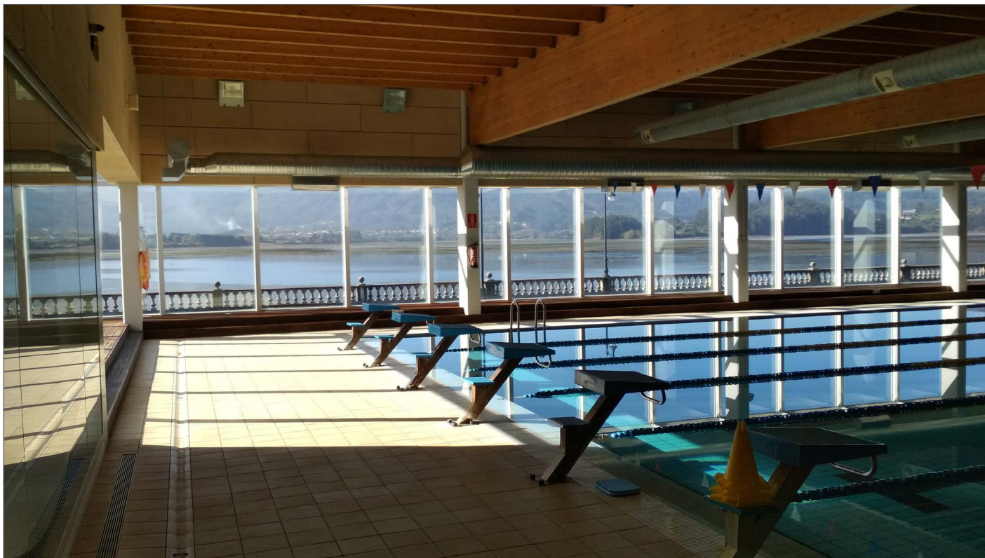
Imaxe da piscina municipal de Ortigueira, que reabriu tras a instalación de novos condutos e equipamento
